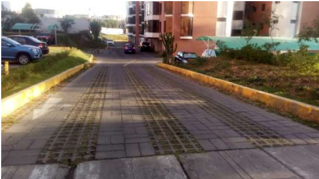
Fotografía N° 3: Área de estacionamiento – Torre IV.
