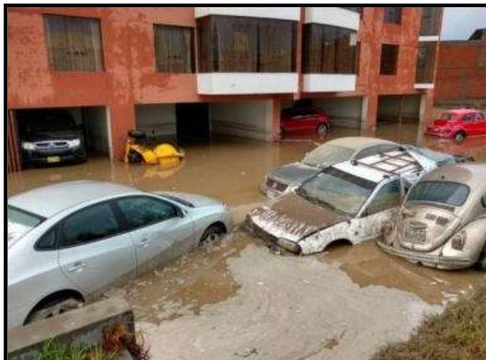
Figura 4: Estacionamiento afectado por aniego en el año 2018 (fuente: Villa Médica).
