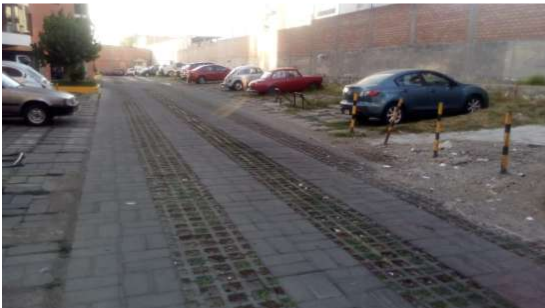
Fotografía N° 2: Área de estacionamiento – Torre V.
