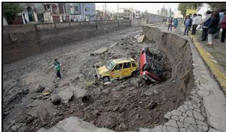
Figura 2: Deslizamiento de tierra a causa de lluvias en la ciudad de Arequipa.
