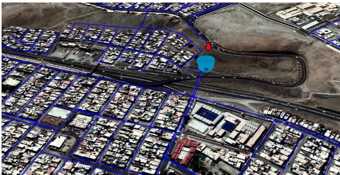
FIGURA 21: punto de ingreso del agua potable al R2
