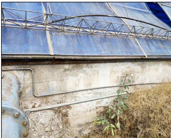
Fotografía 25. Presencia de suciedad en la estructura plástica y en la de concreto. Fuente: Elaboración propia.
