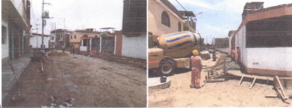
Fotografías 11 y 12: Vaciado de concreto en veredas Personal obrero con implementos de seguridad
