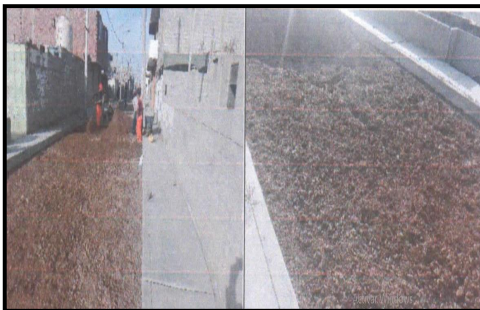
Figura 5: Tendido y esparcido de material afirmado
