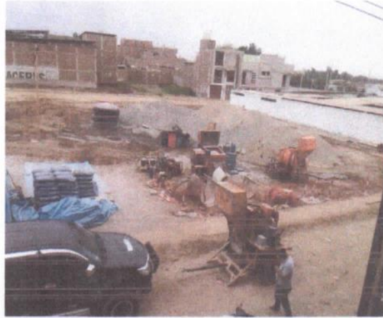
Fotografías 22: Almacén de la Obra, agregados, cemento y equipos livianos
