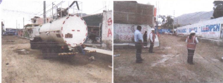
Fotografías 15 y 16: Camión Cisterna y pistas humedecidas
