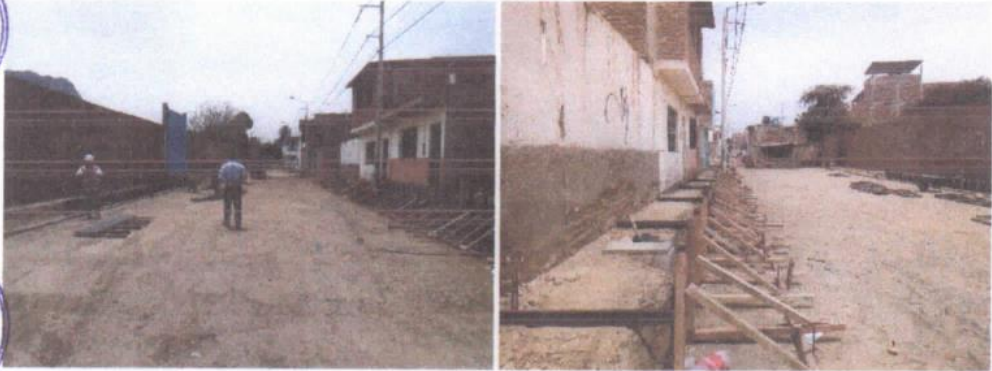
Fotografías 7 y 8: Encofrado de veredas
