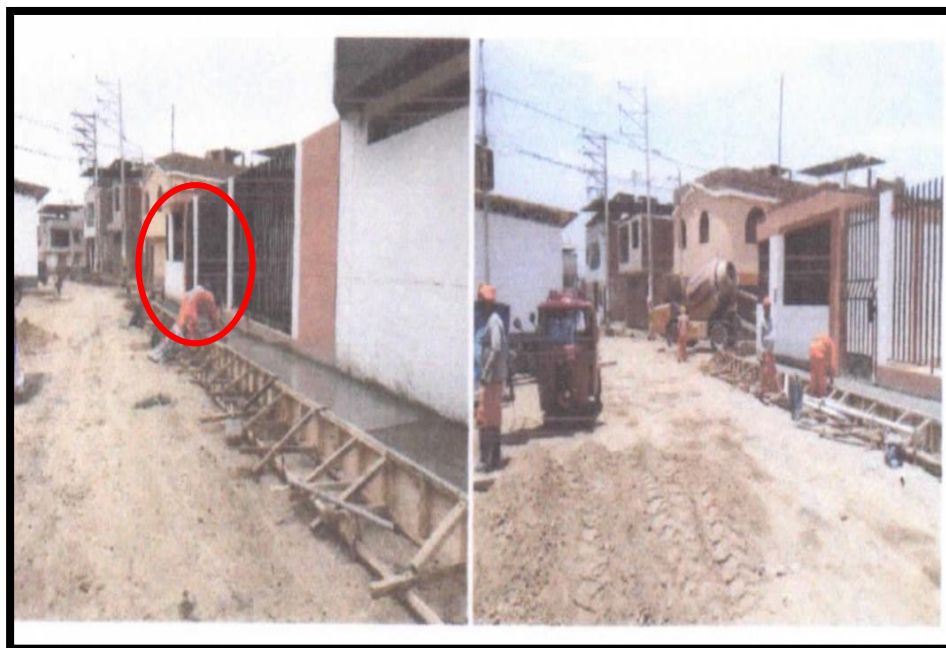
Figura 10: Encofrado y vaciado de concreto
