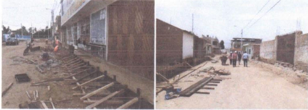
Fotografías 5 y 6: Encofrado de veredas
