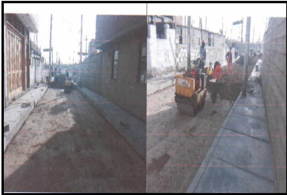
Figura 6: Compactado en la Sud base granular
