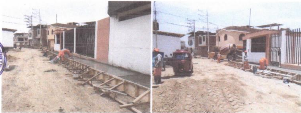
Fotografías 9 y 10: Vaciado de concreto en veredas Personal obrero con implementos de seguridad*
