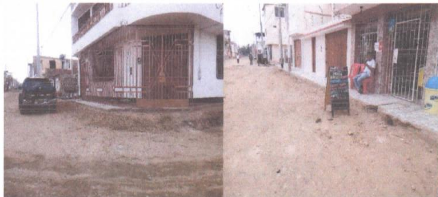
Fotografías 27 y 28: Veredas de concreto o con cerámico existente.
