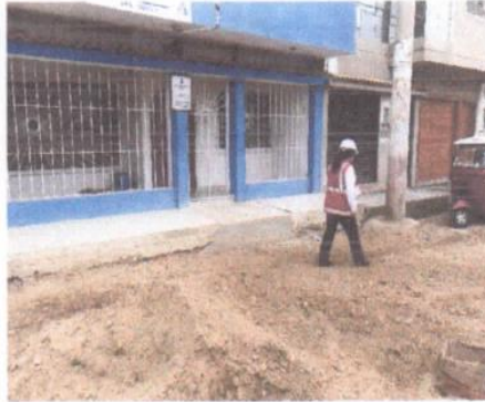
Fotografía 29: Veredas de concreto o con cerámico existente.
