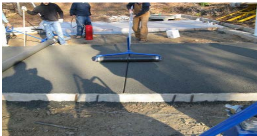
FIGURA N°09: Cimbra de madera sujeta a base de clavijas.
