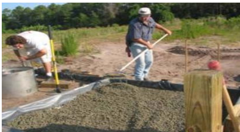
FIGURA N°07: Rastrillado del Concreto Permeable
