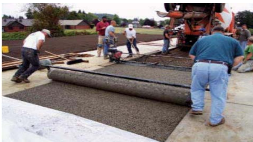
FIGURA N°11: Compactación del concreto permeable
