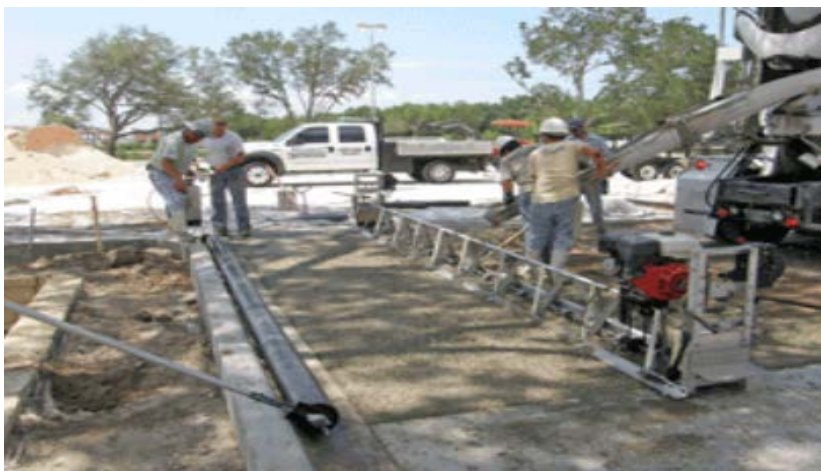
FIGURA N°10: Enrasado del concreto permeable.
