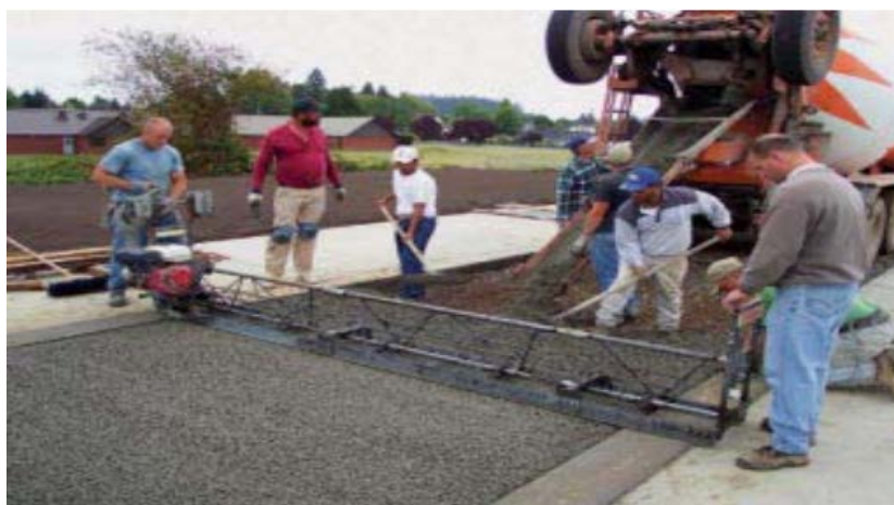
FIGURA N°06: Colocación del Concreto Permeable.
