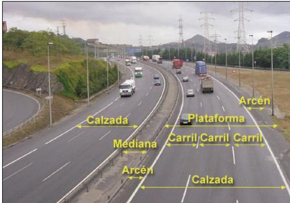
**Figura 30. Partes de una vía**
