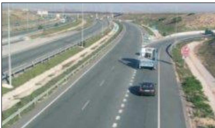
**Figura 34. Carril de desaceleración o de salida**
