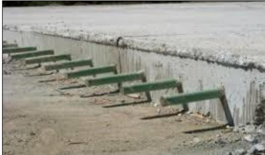
**Figura 38. Pavimentos de Hormigón con Junta Normal**
