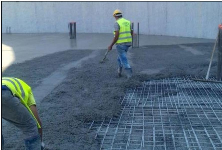
**Figura 40. Pavimentos de Hormigón Armado Continuo**
