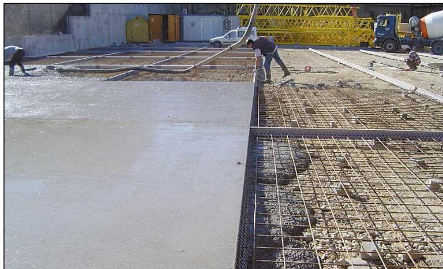
**Figura 39. Pavimentos de Hormigón Armado con Junta**
