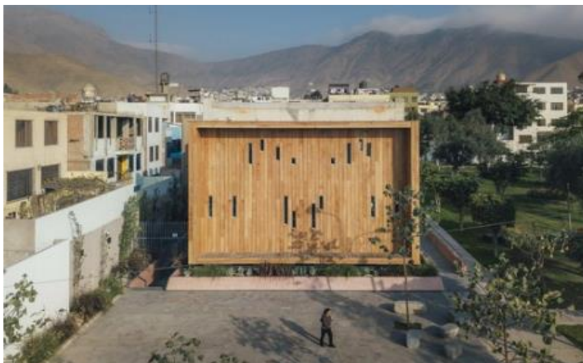
Figura N°3 Vista de biblioteca comunitaria en la Molina
