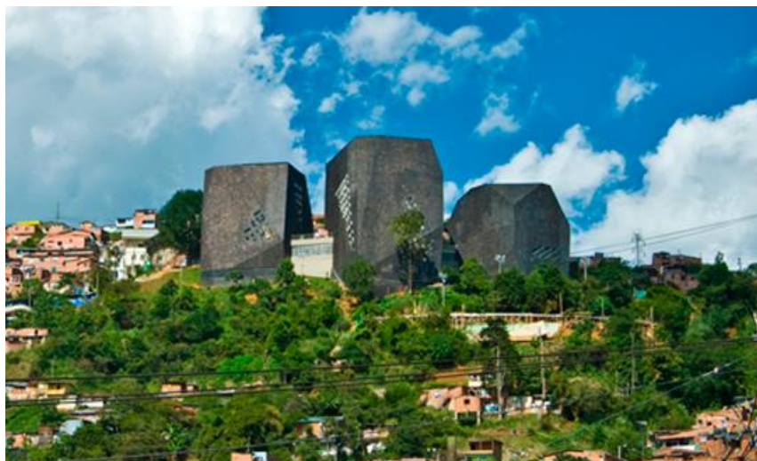
Figura N°2 Vista de biblioteca comunitaria en la Molina
