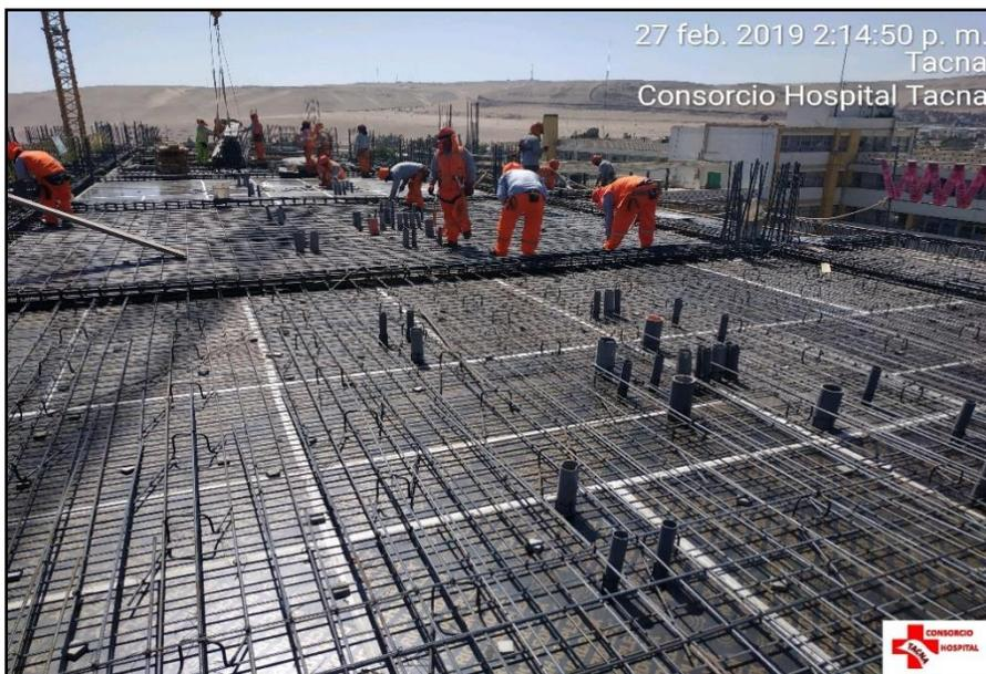
**Fotografía N°11.** Observación de la partida más productiva, el armado losa sector C edificio principal
