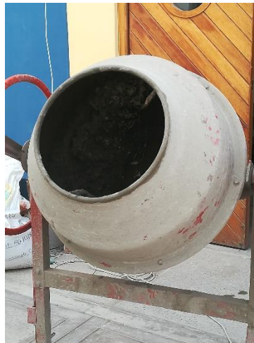
Fotografía 20 Empezamos a realizar la mezcla con ayuda del trompo
