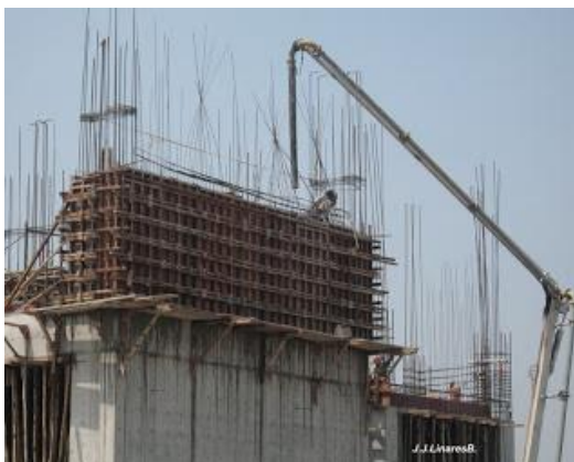
Figura 6 Muro portante de concreto armado (placa)
