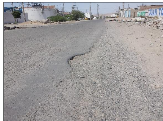
Fotografía 04: Fisura de borde.
