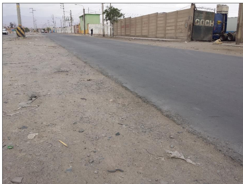
Figura 55. Av. Jorge Basadre Grohmann - Tramo N°02.
