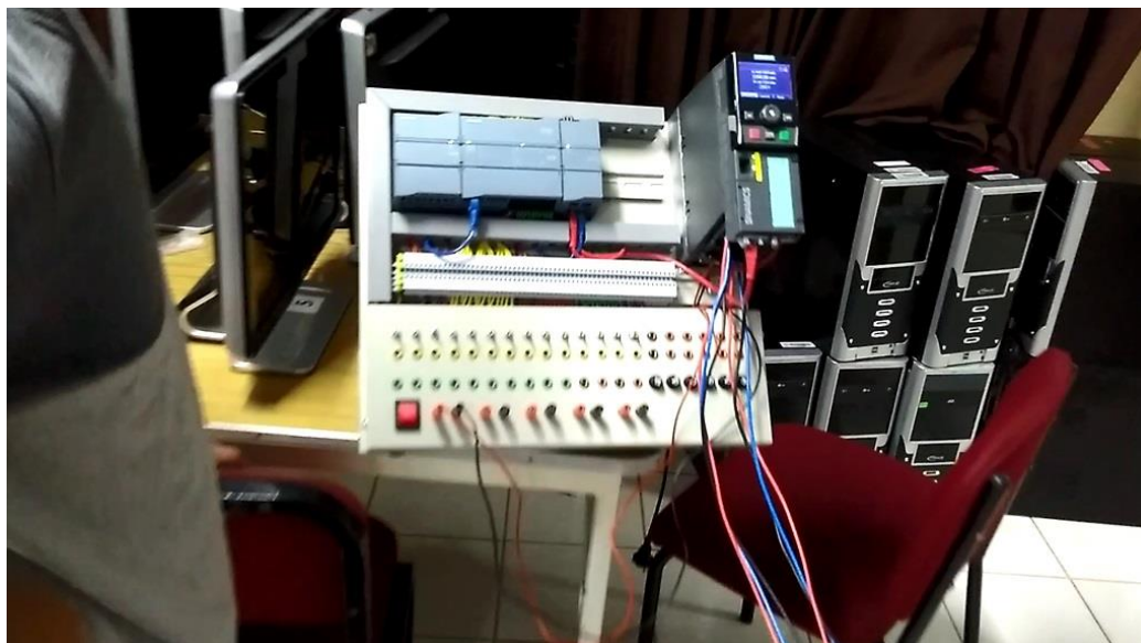
Figura 77: Encendido de equipos y verificación de la Comunicación (Fuente: Propia)
