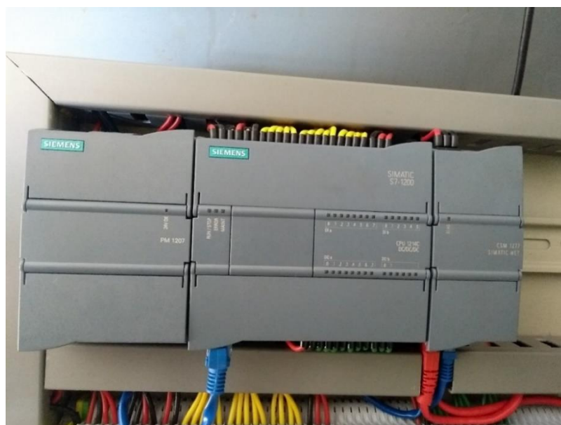
Figura 61: Fuente de alimentación PM1207, PLC S7-1200 Y CSM 1277 (Fuente: Propia)
