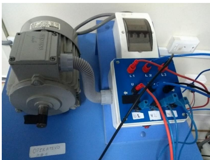
Figura 76: Conexiones del Motor Trifásico hacia el Variador de Velocidad (Fuente: Propia)
