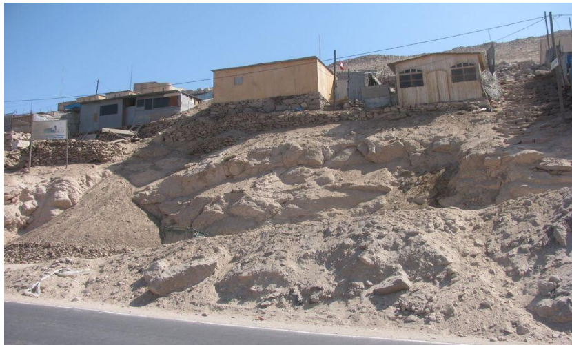
Figura 12. "Viviendas con Peligro de Deslizamiento" Fuente: Elaboración propia
