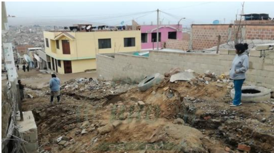
Figura 14. "Suelo ante la Humedad en el Sector" Fuente: Diario Correo
