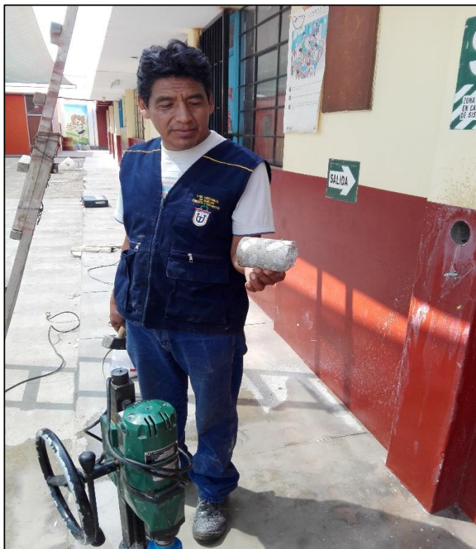
VISTA DEL TESTIGO DE CONCRETO EXTRAIDO
