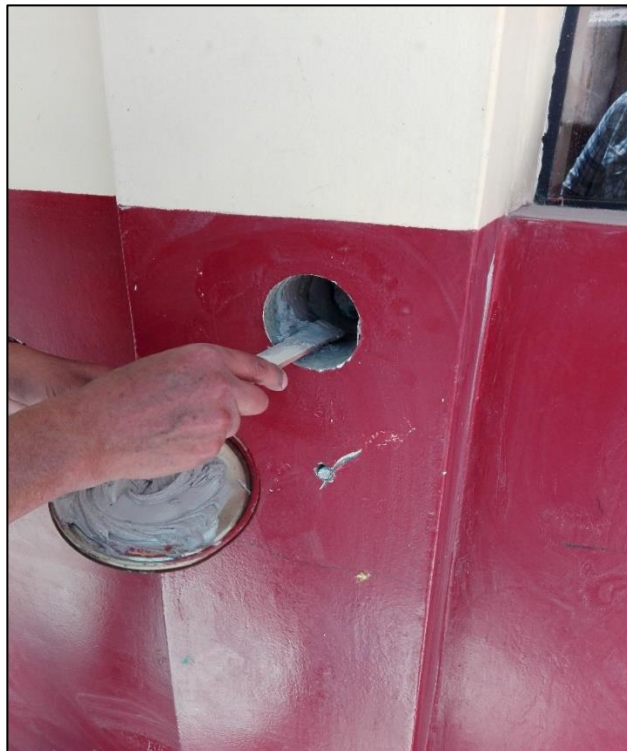
VISTA DE LA REPARACION DE COLUMNA DEBIDO AL ENSAYO DESTRUCTIVO
