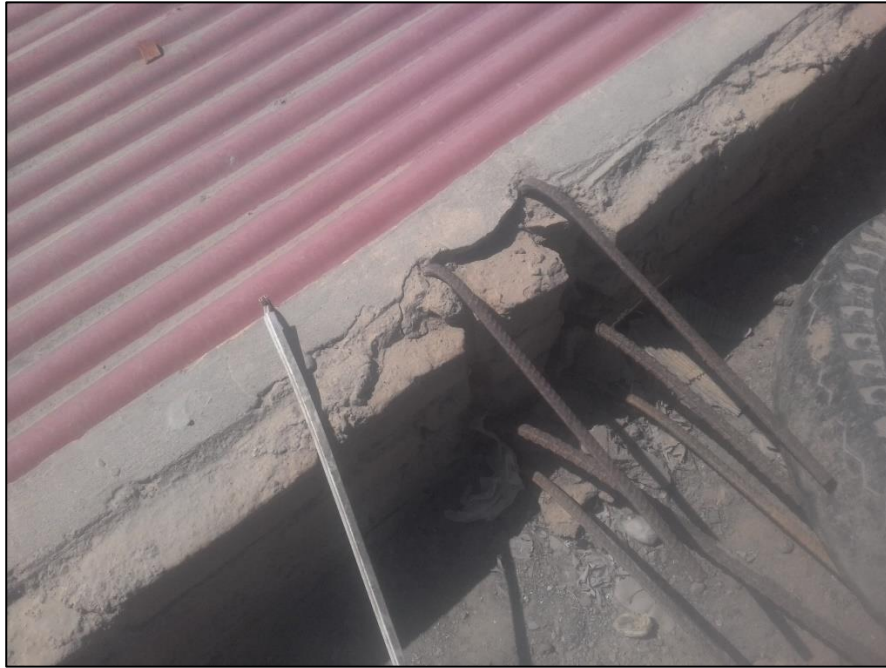
VISTA DE LOS ARRANQUES DE ACERO DE COLUMNAS DEL EJE 9/C
