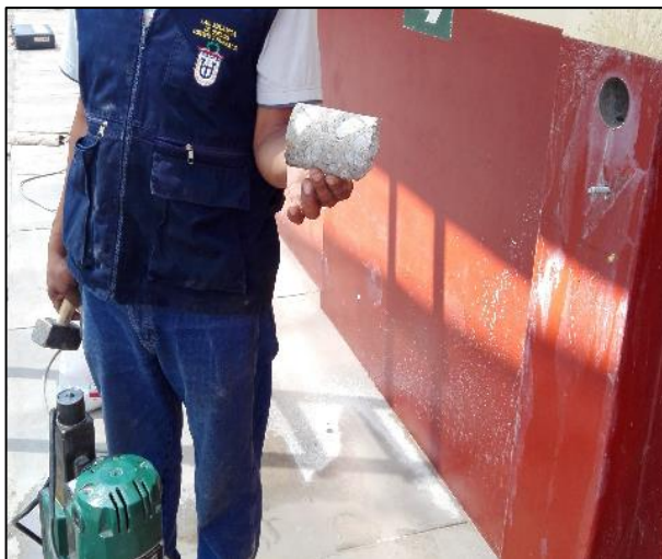
Fig. 4.6 Extracción de muestra M – 1
