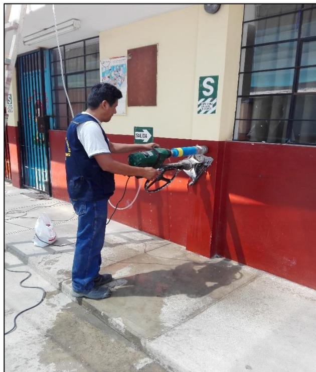
TOMA DE MUESTRO DE CONCRETO CON DIAMANTINA
