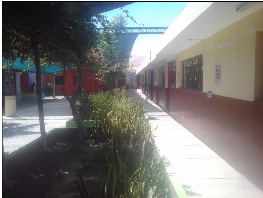
VISTA DEL BLOQUE 1 (ELEVACION PRINCIPAL
