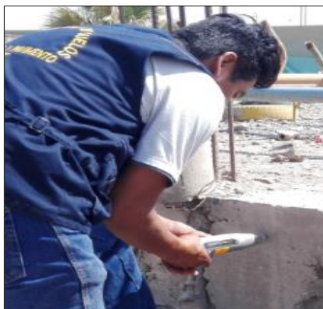
Fig. 4.3 Uso del esclerómetro para verificar la uniformidad del concreto.
