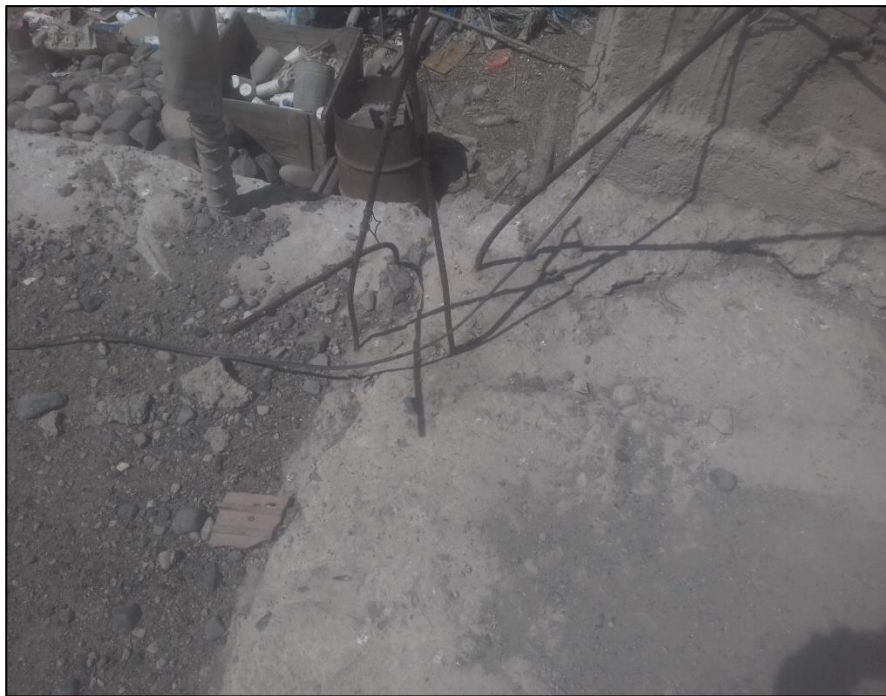
VISTA DE LOS ARRANQUES DE ACERO DE COLUMNAS DEL EJE 3/A
