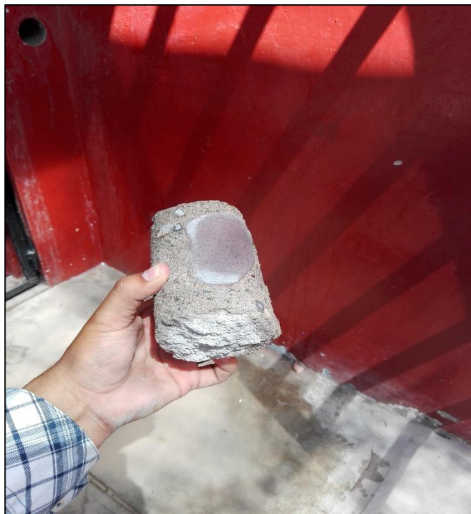
VISTA DEL TESTIGO DE CONCRETO EXTRAIDO
