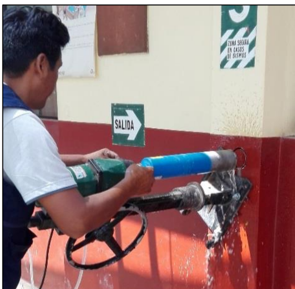
Fig. 4.5 Extracción de muestras usando el equipo con broca diamantada
