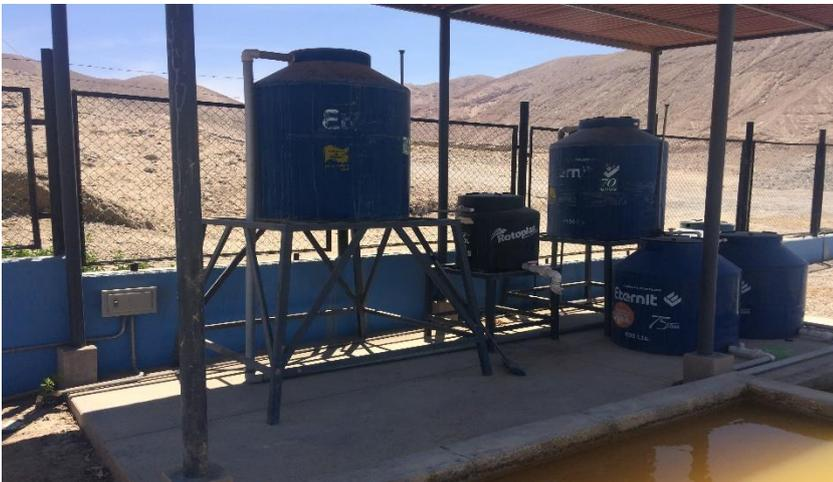
*Fotografía 8. Tanques de cloración*
