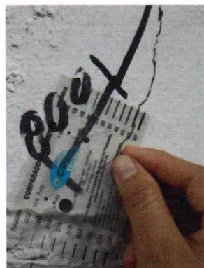
Foto 111. Espesor de grieta de 0.5mm en ladrillo de la cara Norte y Sur para una distorsión de 1/550.
