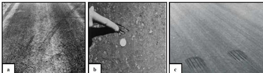
Figura 13: Exudación con distintos niveles de severidad.
