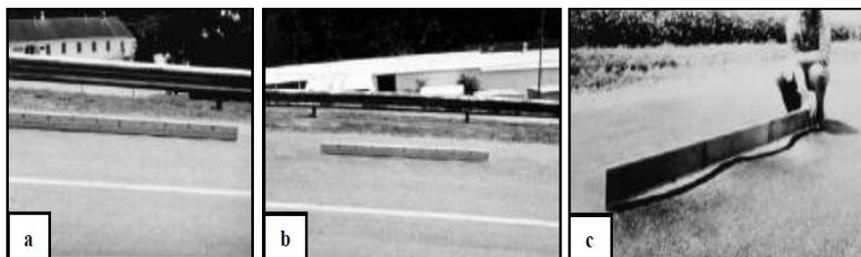
Figura 16: Corrugación con distintos niveles de severidad.
