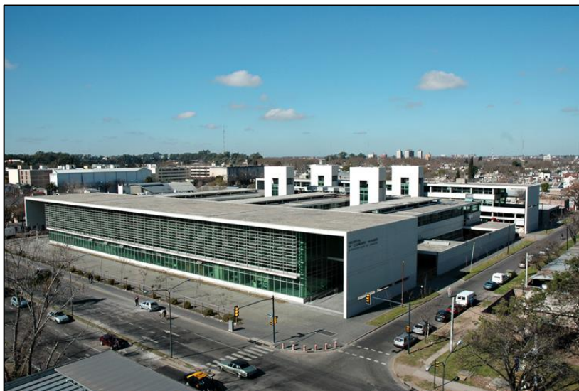
Figura 19 Aspecto estructural del HECA.
