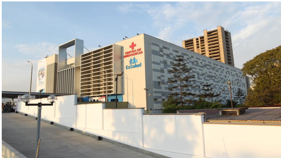
Figura 20 Hospital Rebagliati – Lima.
