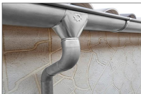
Figura 69. Detalle de Drenaje Pluvial
