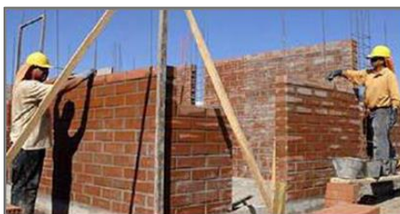
Figura 96. Albañilería Confinada Fuente: Elaboración Propia
