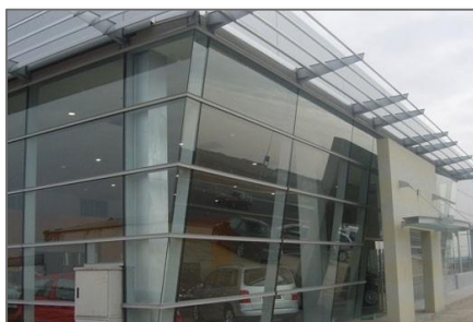
Figura 100. Sistema de Muro Cortina Fuente: Elaboración Propia
