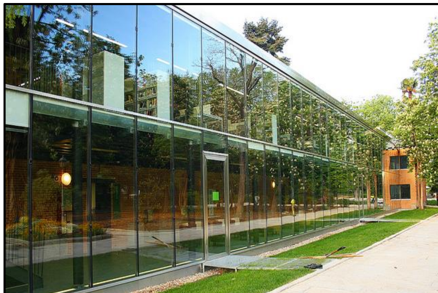
Figura 74. Muro Cortina, sistema spider
