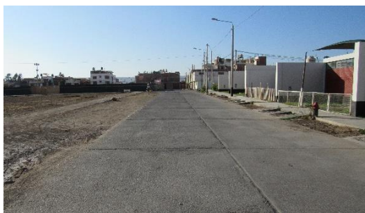
Figura 74: Calle J. de la Rosa Fuente: Elaboración Propia
