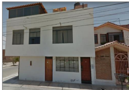
Figura 86: Vivienda de concreto armado y ladrillo - 02 niveles Fuente: Elaboración Propia
