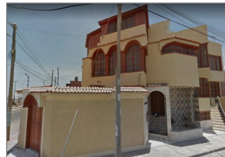
Figura 87: Vivienda de concreto armado, ladrillo - 02 niveles + azotea Fuente: Elaboración Propia
