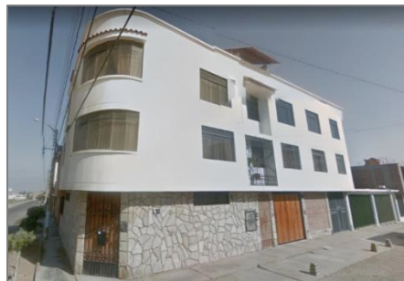
Figura 88: Vivienda de concreto armado y ladrillo - 03 niveles Fuente: Elaboración Propia
