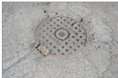
Figura 82: Buzón de red de alcantarillado - calle J. de la Rosa Fuente: Elaboración Propia
