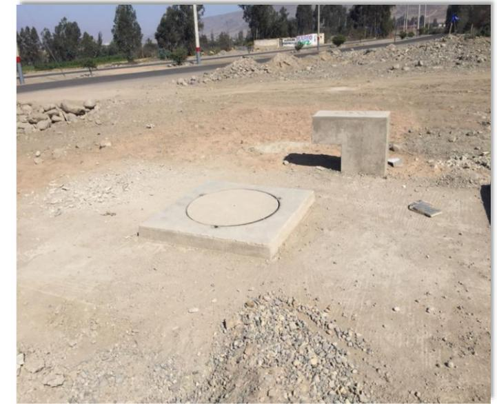
Figura 44 Registro de desagüe en vía proyectada
