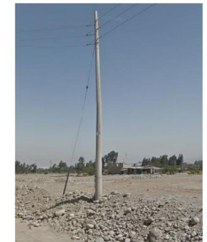
Figura 47 Poste de conexión media tensión
