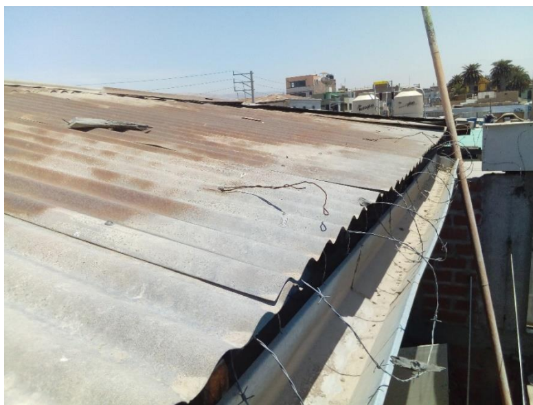
Imagen N°06: No se tiene cubierto los espacios donde ingresan las palomas, que deterioran aún más los materiales de la cobertura.
