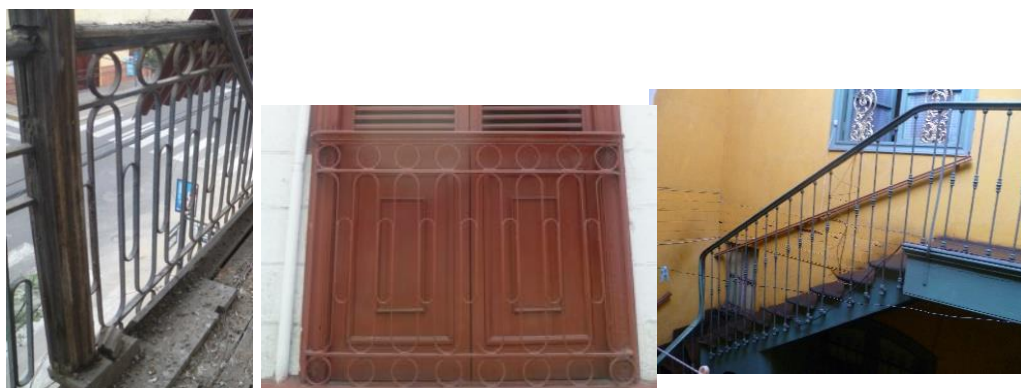
Figura 54. Detalle de barandas
