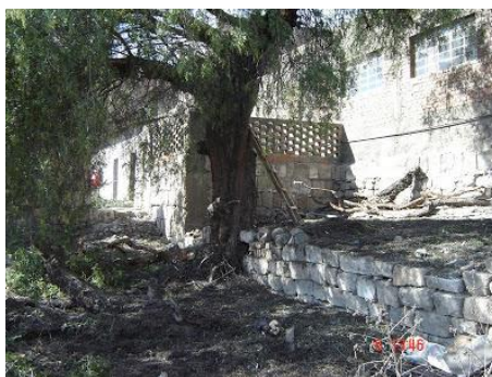
Figura 2. Antes de la intervención del Restaurante Paladar 1900
