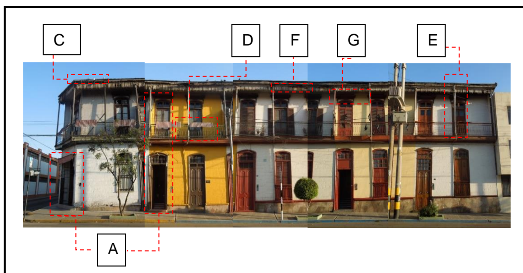
Figura 49. Fachada del inmueble de la av. 2 de Mayo
