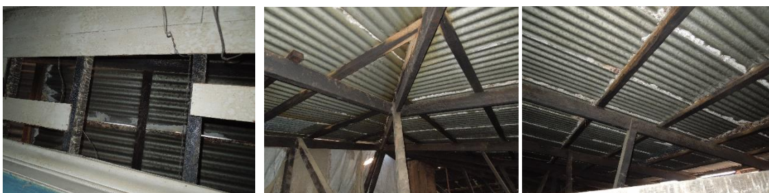
Figura 66. Sistema de cubierta de techo Fuente: Elaboración Propia, Julio 2018
