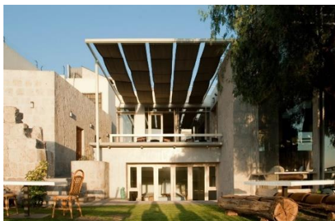
Figura 3. Después de la intervención del Restaurante Paladar 1900
