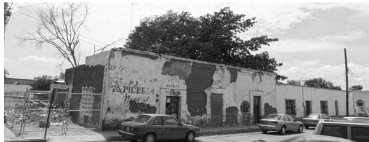
Figura 1. Inmueble a preservar y terreno para la construcción del edificio nuevo que complementará a la edificación antigua Fuente: Archdaily
