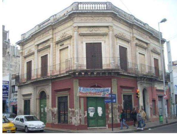
Figura 93. Fachada deteriorada de la Casa Italianizante. Fuente: Archdaily
