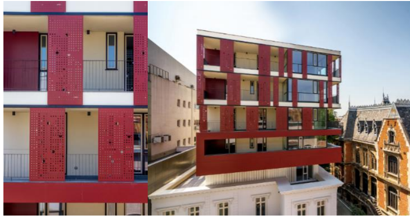
Figura 50. Fachada principal del proyecto donde se observa los paneles perforados Fuente: Archdaily
