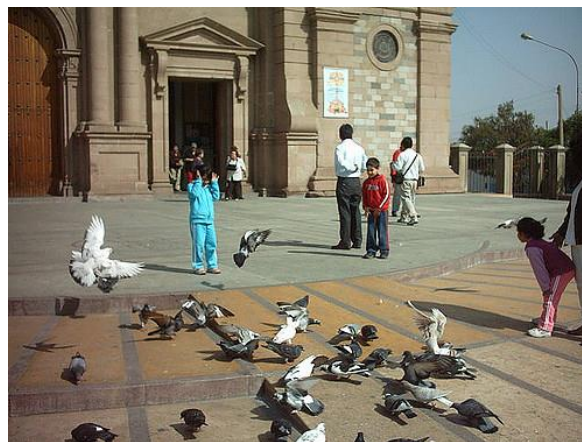
Figura 110. Residuos ocasionados por las defecaciones de palomas, muchas de ellas con nidos en cornisas o aleros de edificios aledaños Fuente: Elaboración propia.
