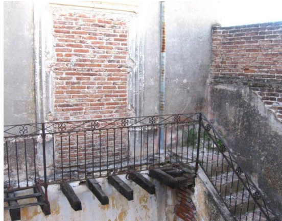
Figura 68. Vista de la escalera Fuente: Archdaily
