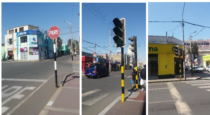
Figura 115. Fotografía de la Av. Patricio Meléndez y la señalización vial Fuente: Elaboración propia
