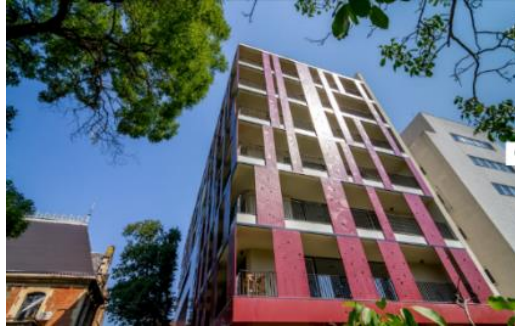
Figura 61. Fotografía de la fachada principal que muestra los paneles perforados que controlan el ingreso del sol Fuente: Archdaily
