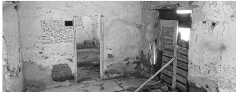
Figura 2. Fotografía interior del Inmueble antes de la intervención Fuente: Archdaily
