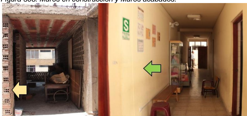
Figura 308. Muros en construcción y Muros acabados.
