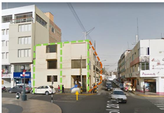
Fachada – calle San Martin
